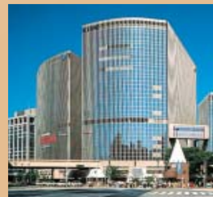
有楽町センタービル(有楽町マリオン)
