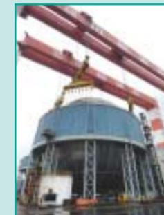
完成したタンクが800トンクレーン2基により吊り上げられる。
