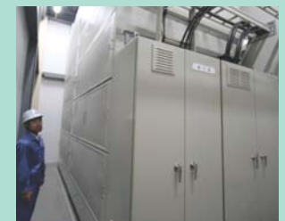
NAS電池 安定した送電力をつくるためNAS電池を用いた制御技術の開発が進められている。
