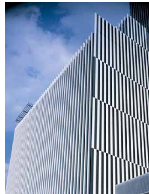
ファサードに取り付けられたセラミックルーバーはアルミの押出材で補強されている。サントリー美術館 ©Mitsumasa Fujitsuka
