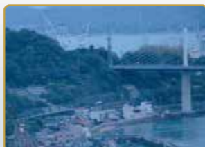
尾道水道(広島県)
