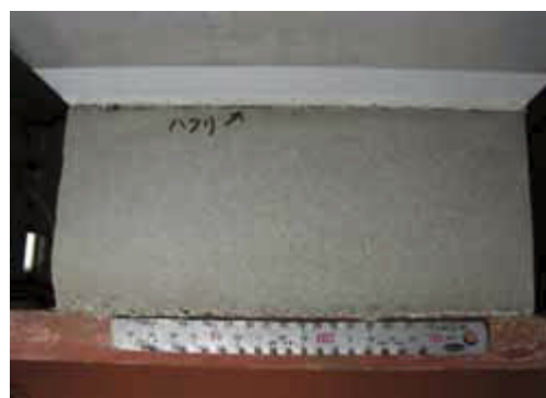
図43 台座モルタル上面の肌隙
