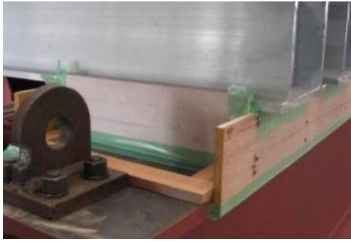
図 30 台座モルタル用の型枠の設置
