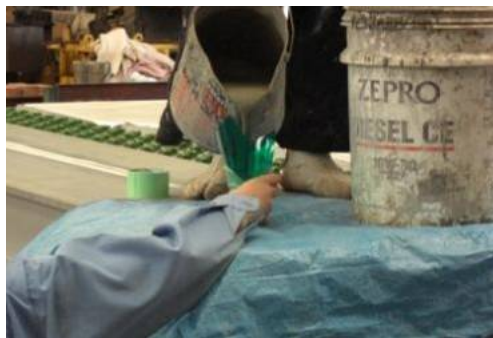
図 31 無収縮モルタル注入の様子
