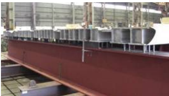
図 26 床版ユニットの位置決め
