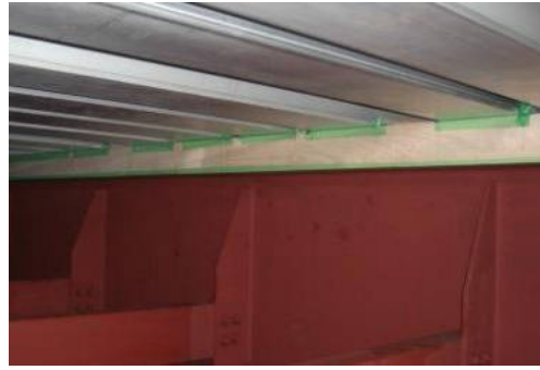
図 30 台座モルタル用の型枠の設置
