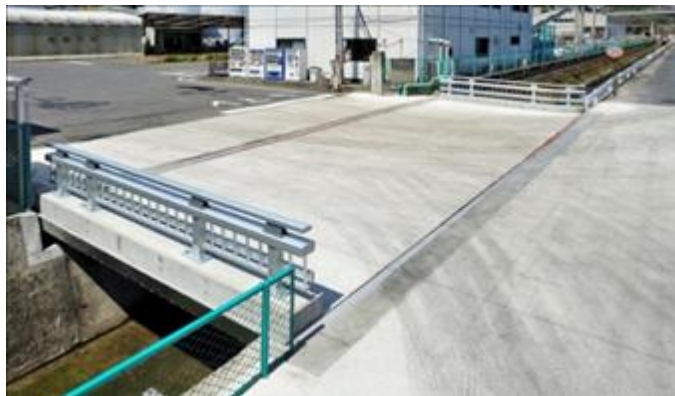
図 1.3 道路用アルミニウム床版を用いた鋼桁橋
