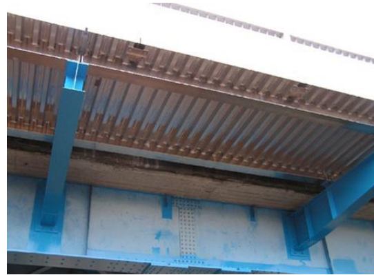
図 1.2 拡幅歩行者用アルミニウム床版
