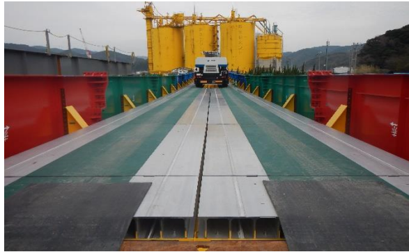
図 1.4 アルミニウム床板が採用された緊急仮設橋
