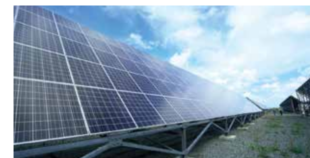
太陽光発電モジュール
