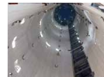
シャフト内部
