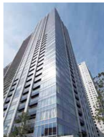
ビル外壁およびカーテンウォール
