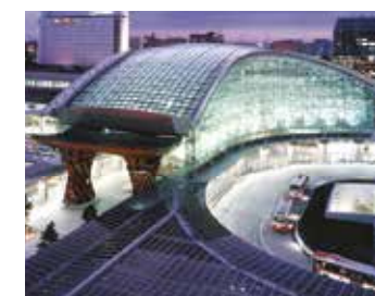
アルミトラス構造体が採用された大屋根
