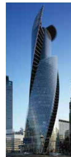
ビル外壁を彩るアルミ建材
