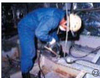
溶接などのアルミ加工技術の蓄積が船の品質を高める
