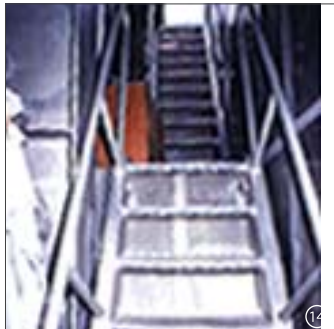
軽量化のため主船体はすべてアルミ製(左)客室への階段(右)車両甲板内部(建造中)
