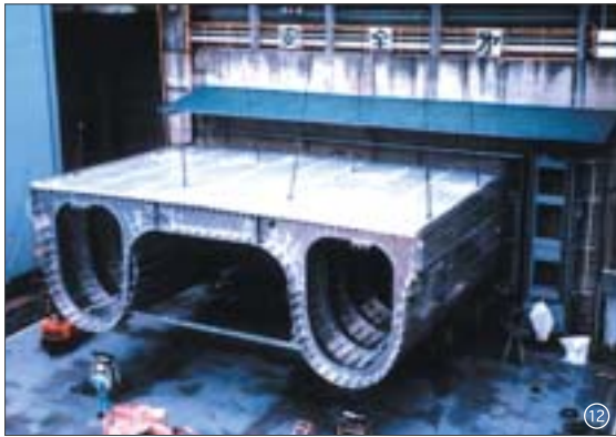
船体は分割されたブロックを溶接してつなぎに建造された
