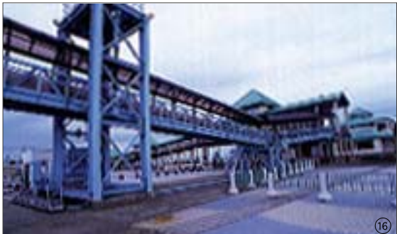
有明海は一日の潮の干満差が5m以上もあり、人道橋やランプは干満に対応できるようにしている。人道橋シェルターは塩害に強いアルミ製
