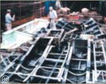
船体は25のブロックに解体されてシュレッダーにかけられた
