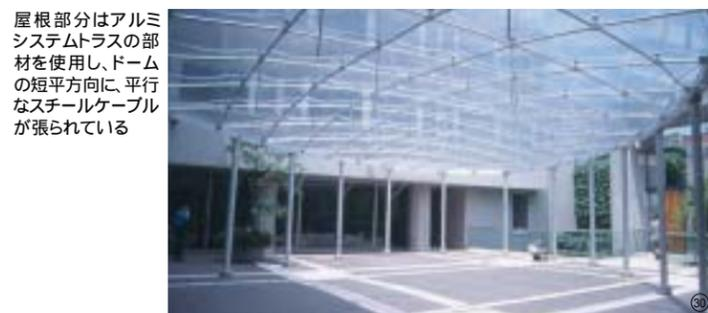
屋根部分はアルミシステムトラスの部材を使用し、ドームの短平方向に、平行なスチールケーブルが張られている
