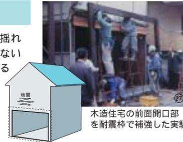
木造住宅の前面開口部を耐震枠で補強した実験
