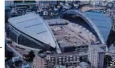
ドームを覆うアルミ屋根。第二期工事も含めると約29,000㎡と日本最大のアルミドーム屋根が完成する
