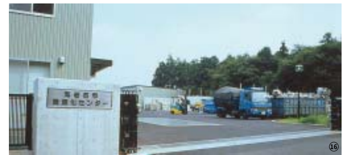
資源ごみが集められる資源化センター
