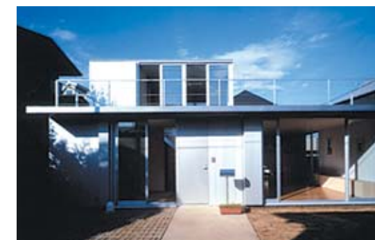
「アルミの家」は構造材と仕上げ材が一体化し、美しい輝きを放つ
