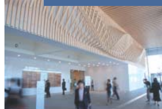
「インタラクティブ」をテーマにした壁面アートは、アルミニウム材に木のシートを張ったフレームを使用し、木の質感を持ちながら軽量に仕上げられている
