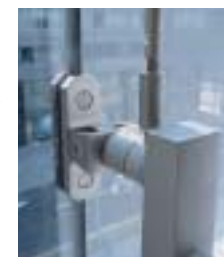
アルミニウム製の留め金具がアトリウムの大きなガラスを支える
