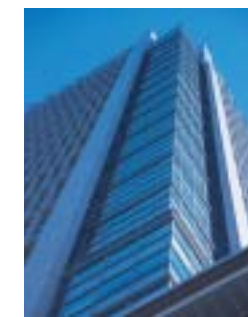
コーナーにはアルミニウムカーテンウォールが使用され、角部屋の眺望が確保されている
