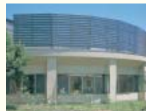
太陽電池モジュールを一体化したアルミ製ルーバーは、高い意匠性を発揮する。
