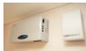
太陽光を受け発電した電力を、家庭で使える交流電力に変換するパワーコンディショナ。
