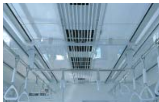
車両室内では、化粧板、窓枠、表示板カバー、広告吊り、吊り手ブラケットなど、さまざまな箇所にアルミ部品が使用されている。
