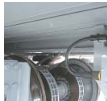
車両の床下。床板のアルミ大型押出材には、制御装置等を吊り下げるレールが一体化されている。
