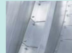
裏側をみると、スキンの曲面に合わせてアルミ押出材がリベット接合されている。
