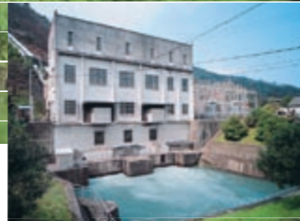
波木井発電所
