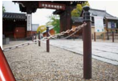
上部の飾り以外は、アルミニウムの無垢材を使用している車止めのポール
