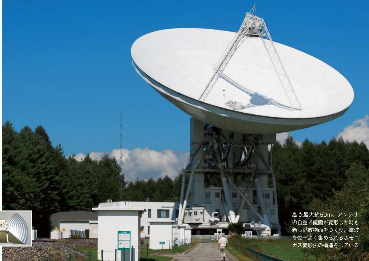
高さ最大約50m。アンテナの自重で鏡面が変形した時も新しい放物面をつくり、電波を効率よく集められるホモロガス変形法の構造をしている
