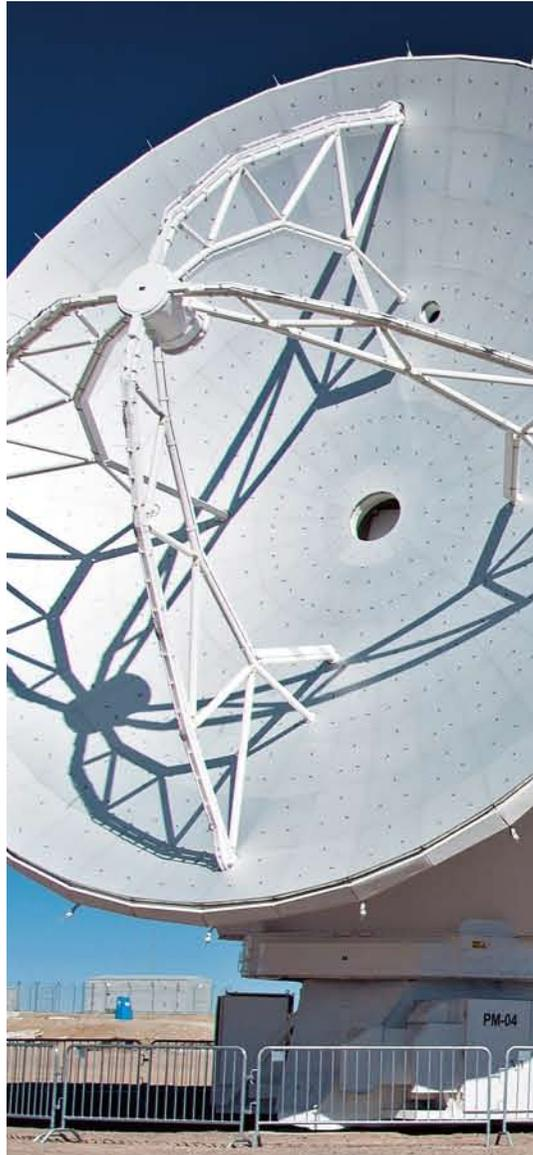
(上) アンテナ鏡面の調整作業は、リフトに乗って慎重に行われる (写真提供：国立天文台) (下) 電波は大きな主反射鏡で受け、突起している中心の副反射鏡に集めて、受信機に送られる (写真提供：ALMA [ESO/NAOJ/NRAO])
