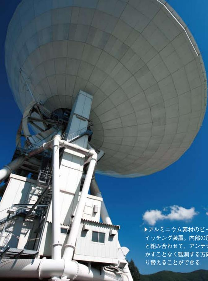
▶アルミニウム素材のビームスイッチング装置。内部の反射鏡と組み合わせて、アンテナを動かすことなく観測する方向を切り替えることができる
