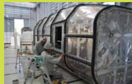
アルミ製津波シェルターの建造のようす。アルミ板の骨格に曲面のアルミ板を溶接し、シェルターの形を作り上げていく。
