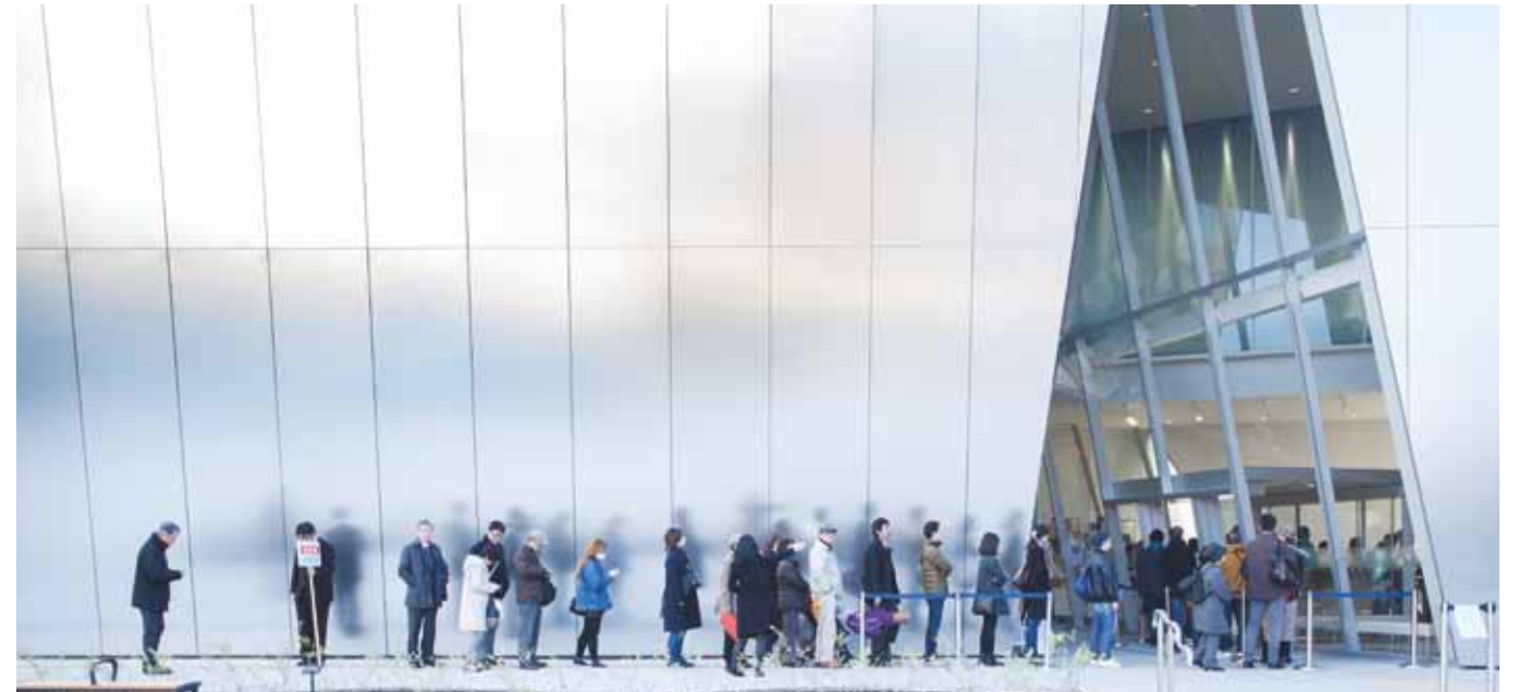
館内の入口に最も近い北側は映り込みがやや強い。(写真提供: (株)妹島和世建築設計事務所)
