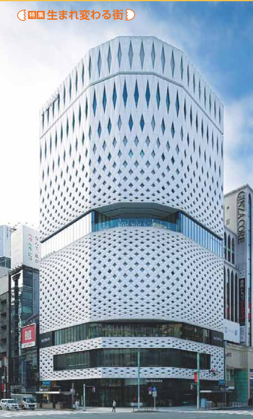
(上) 白い外壁はアルミパネルにポリエステル系粉体焼付塗装が施されている。菱形のパネルが組み合わせり優美なカーブを描く。表面には凹凸が付けられ太陽の傾きで陰影をつくる。(下) パネルの縦の比率が上にいくほど大きくなり、建物が天高く伸び上がるよう。アルミパネル1枚の大きさは幅965×高さ1010mm、外装総面積は2658㎡。材質はアルミ合金(4000系合金)を使用。
