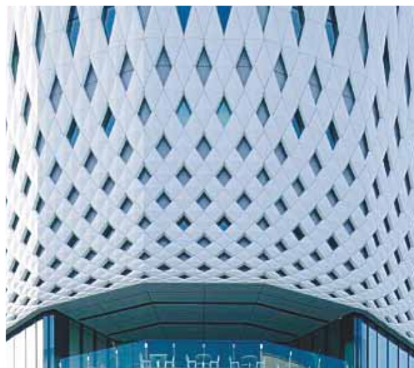
(上) 白い外壁はアルミパネルにポリエステル系粉体焼付塗装が施されている。菱形のパネルが組み合わせり優美なカーブを描く。表面には凹凸が付けられ太陽の傾きで陰影をつくる。(下) パネルの縦の比率が上にいくほど大きくなり、建物が天高く伸び上がるよう。アルミパネル1枚の大きさは幅965×高さ1010mm、外装総面積は2658㎡。材質はアルミ合金(4000系合金)を使用。
