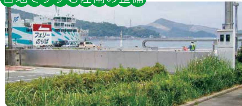
横幅16mの大きな陸閘。非常用発電機が取り付けられている。(三重県・鳥羽港)
