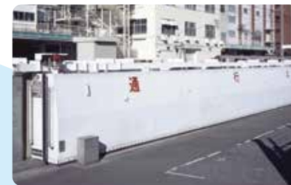
先端の黒い部分はゴム。金属部分とぴったり重なり水を食い止める。(静岡県・清水港)
