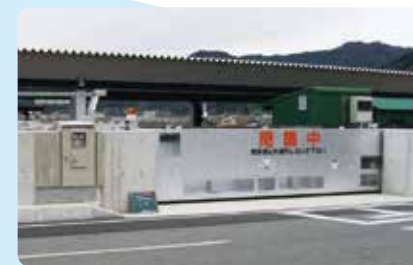
漁港海岸に設置されている横幅5mの陸閘(和歌山県・阿尾漁港海岸)
