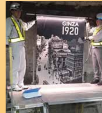
ホームでパネルに照明を当てて見え方を確認。アルミパネルは軽量なため施工もしやすい。
