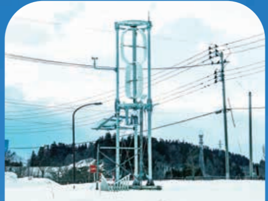
開発中の風力発電機。アスター発電機が微風でも回転し、電気を生み出す。コンパクトな躯体は運搬・設置・保守性に優れ、災害時にも頼れる存在に。
