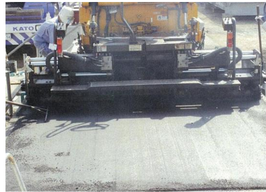
図 E. 3 基層の敷き均し
