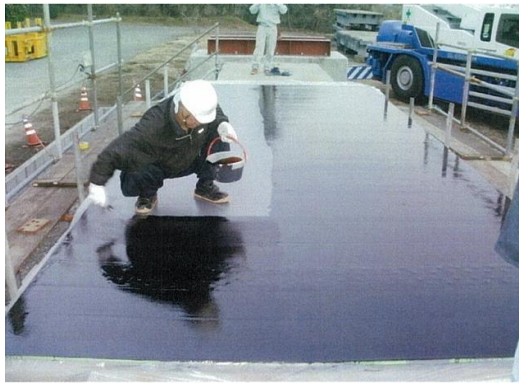
図 E. 2 防水工
