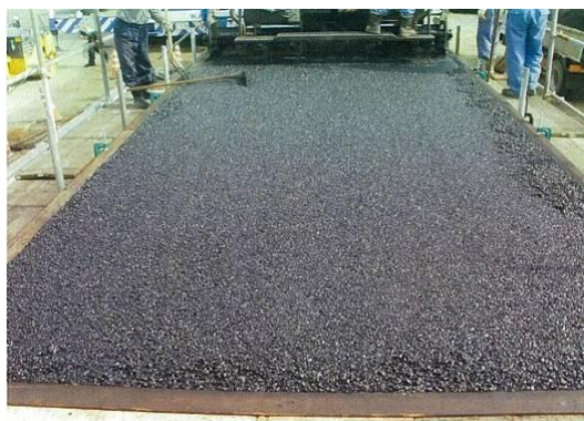
図 E. 6 表層の敷き均し
