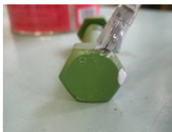
図 D1.4 下地塗料の塗装
