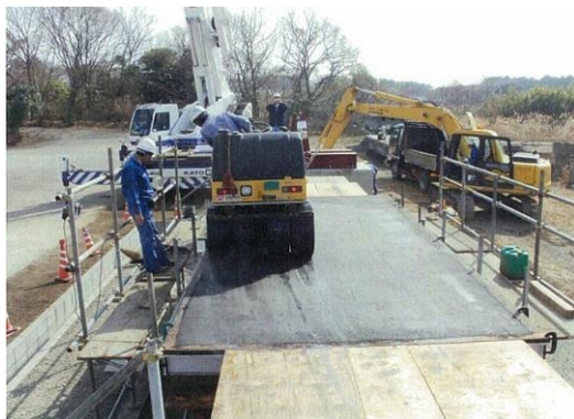
図 E. 4 基層の転圧
