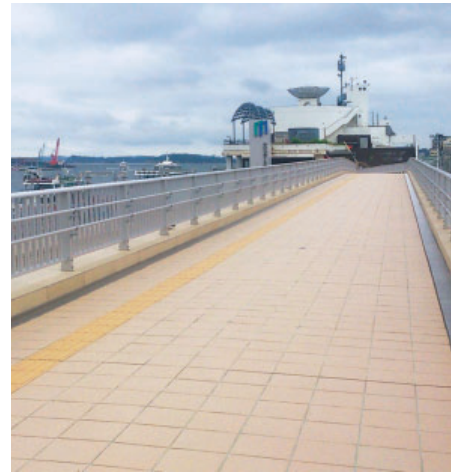
塩竈津波避難デッキ（宮城県）
