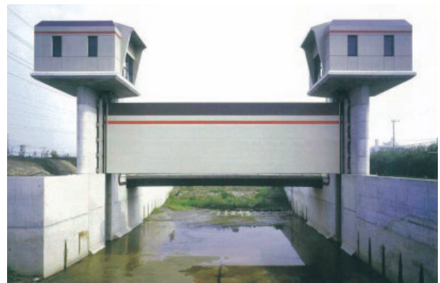
アルミニウム合金製ローラ式水門（本文中指針案より）
