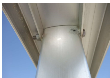
(d) バラスター・トップレール取付部 古宇利大橋（設置後8年）
