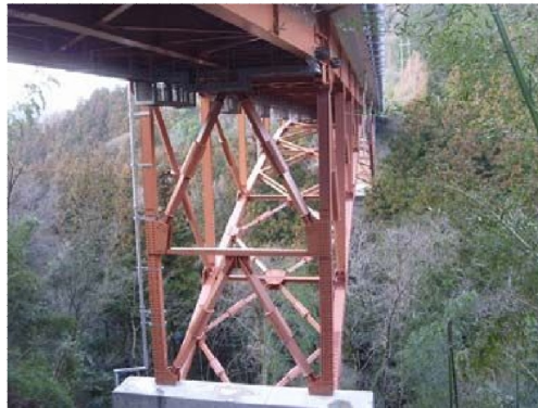
写真-2 制震ダンパーの設置状況
