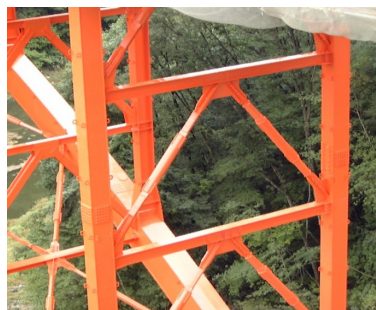
写真-1 制震ダンパーの設置状況
