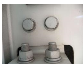
図-6 ダクロ処理を施したボルトの状況（南浜1号橋 設置後11年経過）
