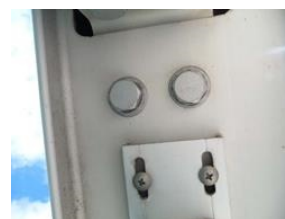
図-6 ダクロ処理を施したボルトの状況（南浜1号橋 設置後11年経過）
