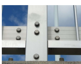
図-6 ダクロ処理を施したボルトの状況（南浜1号橋 設置後11年経過）
