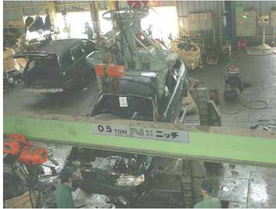
写真6．解体作業の様子
